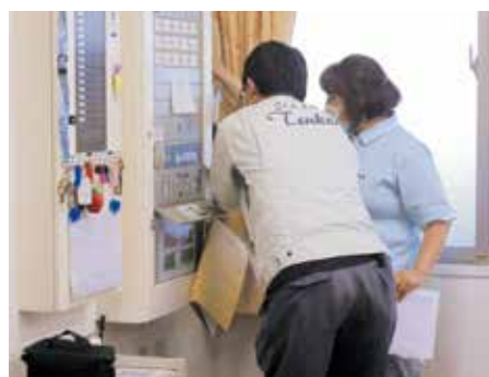
消防への通報・操作盤の操作
